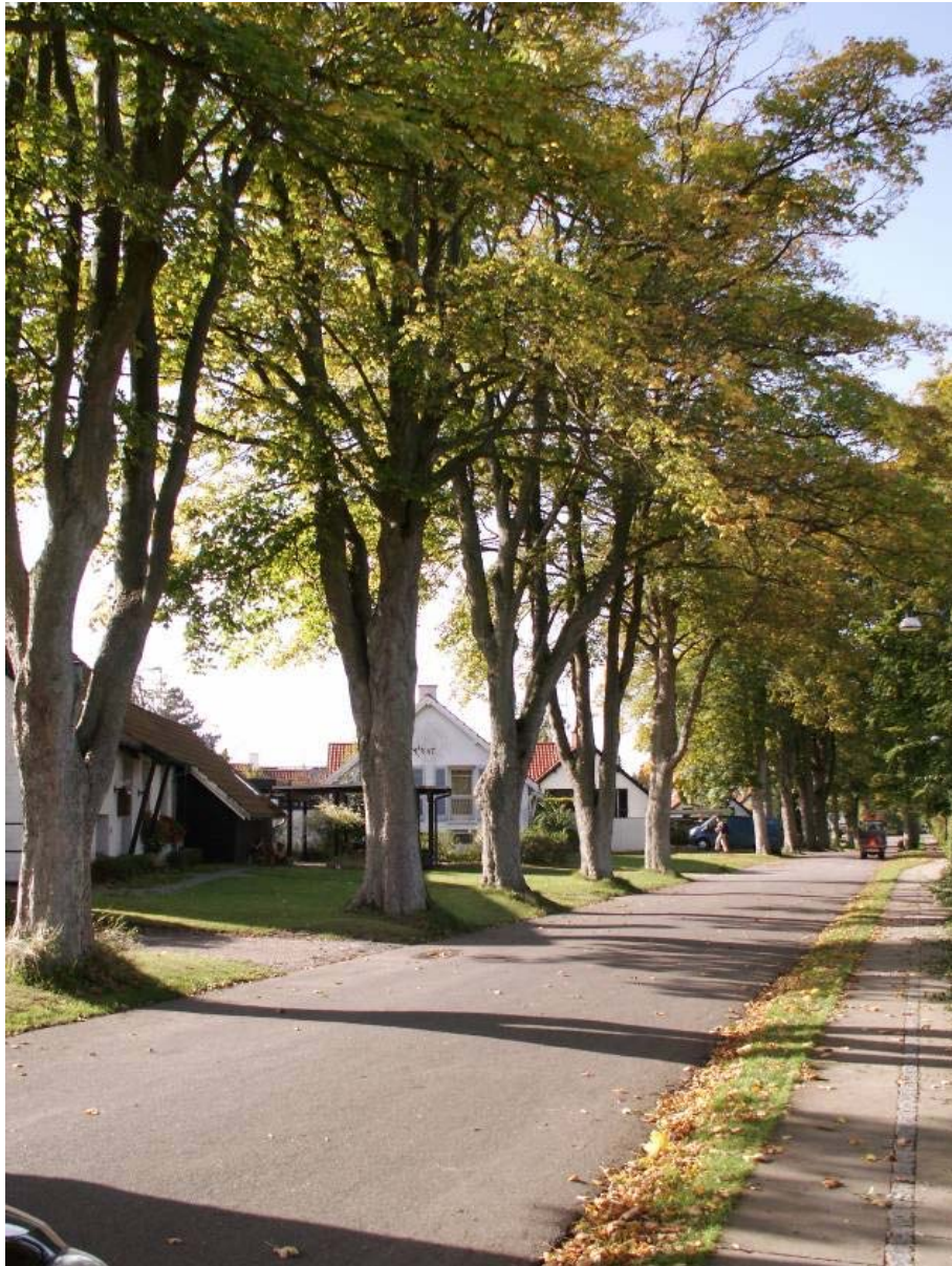
Billedtekst - Bebyggelsen blev opført med statslån i 1947. Alle- en markerede den vigtige vej mellem den oprindelige landsby Nærum og arbejdspladserne ved Mølleåen.
