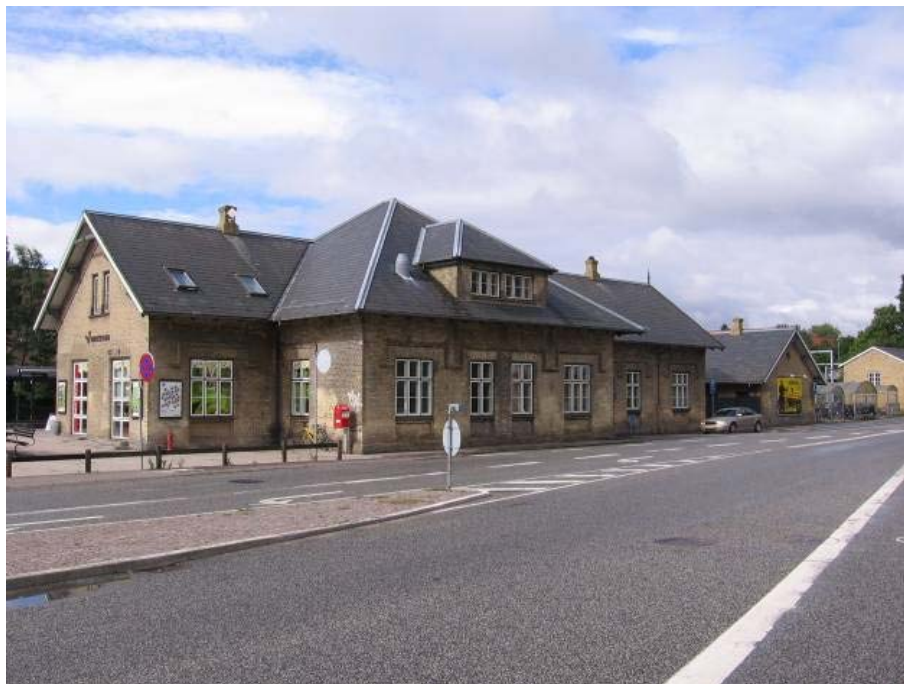
Billedtekst -Birkerød Station. Bygningen er fuldstændig typisk for den stil, der siden kom til at hedde "jernbanearkitetur".
