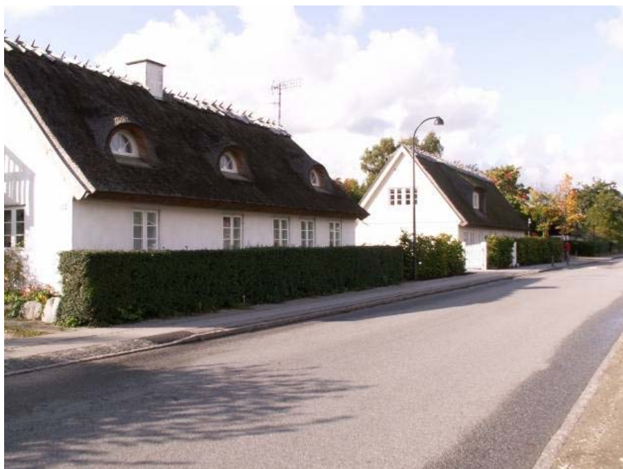
Billedtekst - De velbevarede landsbyhuse ligger fint på række langs gadens vestlige side. Et karaktertræk, som byen har bevaret gennem de sidste godt 300 år.
