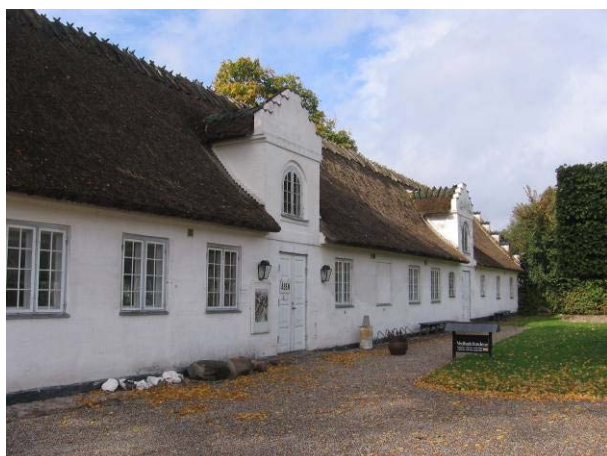
Billedtekst - Den ene af de to længer, der rammer udsigten til hovedbygningen ind. Oprindeligt var det gårdens driftsbygning.
