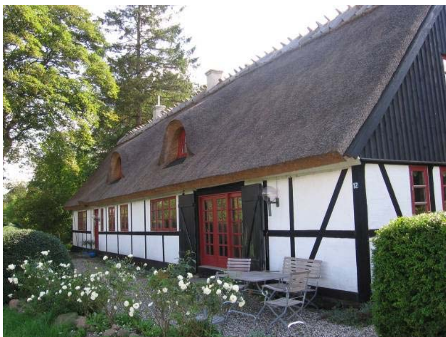
Billedtekst - Velholdt landsbyhus på Nedenomvej. Huset rummer flere træk, der er karakteristiske for den lokale byggeskik: De brede fag, det spinkelt dimensionerede tømmer samt sugfjælen og "kragetæerne" på mønningen.
