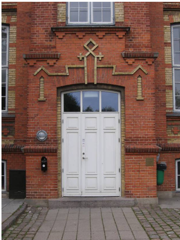
Billedtekst - Dørparti fra sidehus til hovedbygningen.
