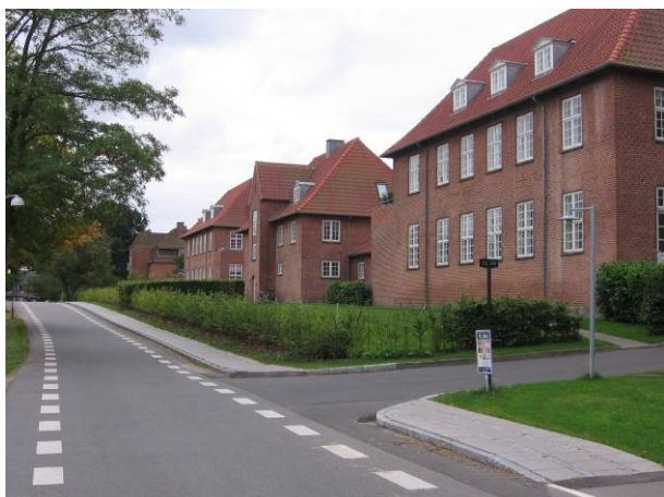
Billedtekst - Facaderækken i den nationalromantiske bygningsgruppe tættest på indkørslen til området.
