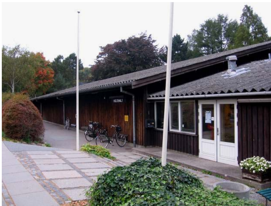
Billedtekst - Holtehal 1 med indgangspartiet. Denne, som er den ældste af de to halbygninger, er arkitektonisk indpasset i terrænet, og med den mørke træfacade meget lidt dominerende.
